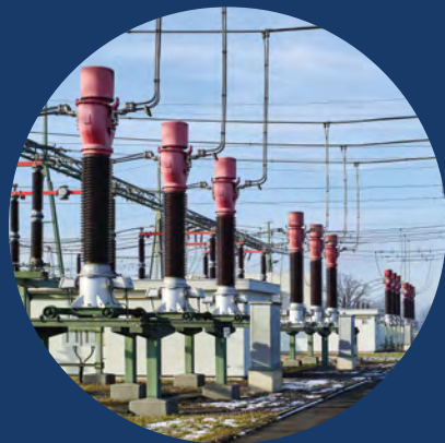
Errichtung Umspannwerk Hofsteig
